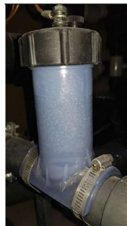
FIGURA 5- Ânodo de sacrifício e instalação no circuito da água da piscina.
