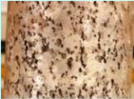
Corrosão por picadas (alveolar)
