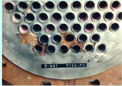
Corrosão por par galvânico - Espelho de Permutador de Calor
