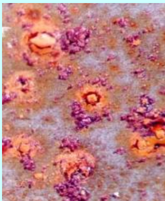
Corrosão Alveolar Generalizada
