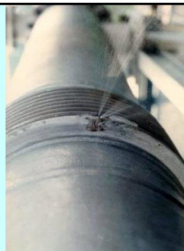
Corrosão por fadiga numa junta de expansão
