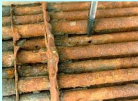
Corrosão Localizada em Feixe de Permutador de Calor
