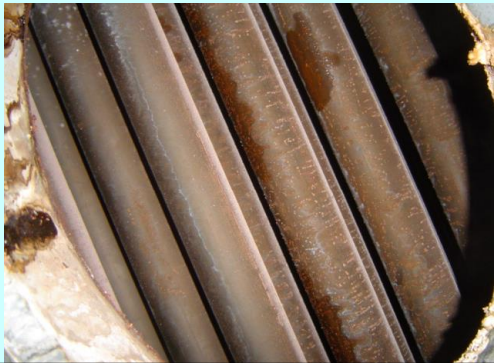
Tubulação de caldeira livre de corrosão e incrustações.
