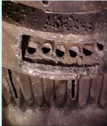
Obstrução na parede aquatubular na fornalha
