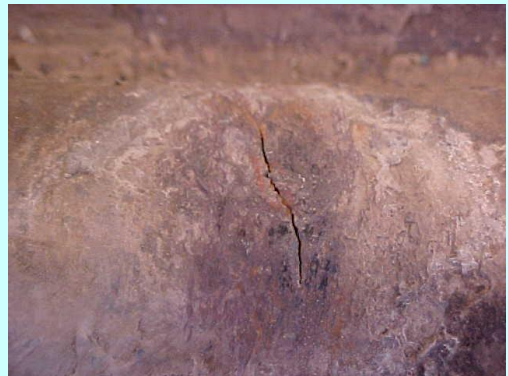
Trinca em tubo de grelha de caldeira causado pela presença de Depósitos no lado interno que impediu a sua refrigeração.
