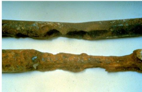
Corrosão induzida por cloretos
