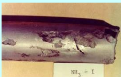
Corrosão por amônia
