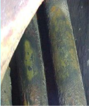
Corrosão puntiforme em caldeira flamotubular
